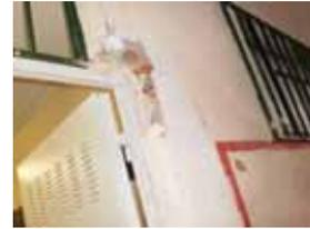
Figura 10. Ausencia de material en el marco de la puerta. Fotografía: PhvA14.
