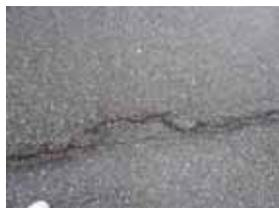
Figura 6. Importante grieta en el pavimento del patio. Fotografía: PhvA12.
